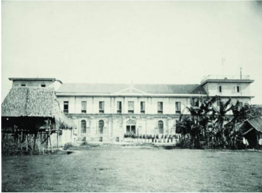
Chofré y Cía.: Fachada actual sin terminar, Patio interior (Álbum Escuela Normal de Manila ), 1887. BIBLIOTECA NACIONAL, Madrid
