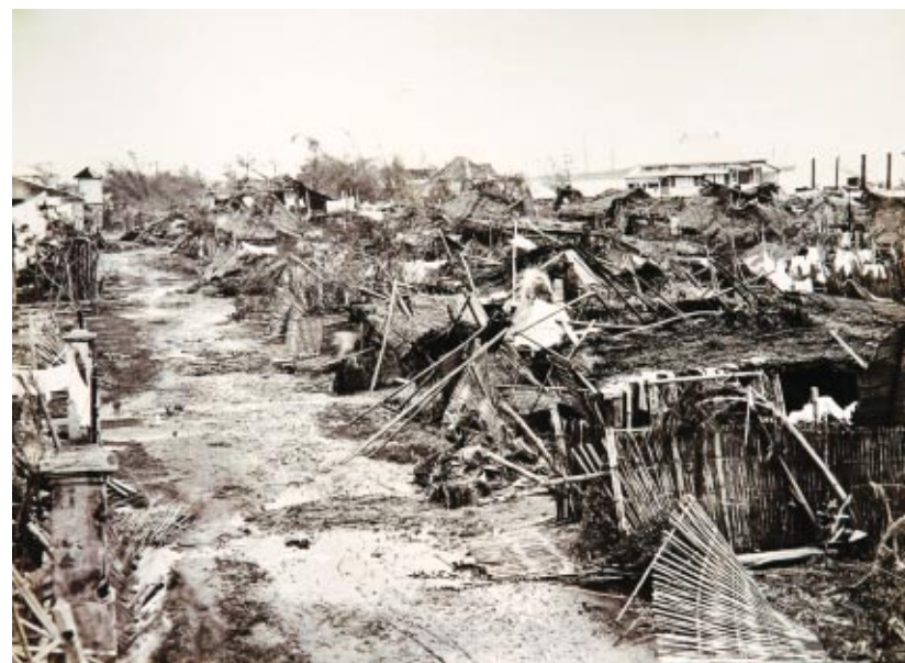
Francisco van Camp: Vista del barrio de Ermita (Manila) tras el terremoto de 1880, 1882. MUSEO ORIENTAL. REAL COLEGIO PADRES AGUSTINOS, Valladolid
