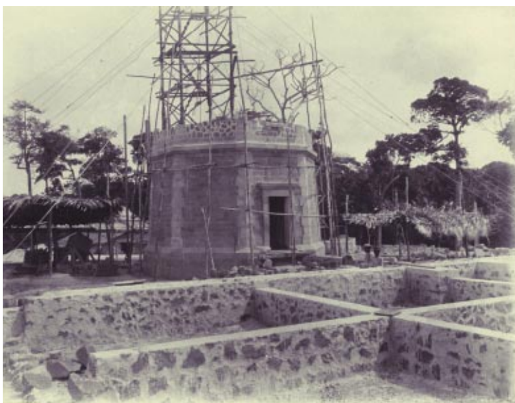
Marion: Faro de 1 er orden de Cabo Melville: Estado de las obras el día 3 de diciembre de 1890, Estado de las obras el día 6 de mayo de 1891 y Estado de las obras el día 18 de febrero de 1892 (Carpeta Islas Filipinas. Obras públicas. Faros ), 1893. PATRIMONIO NACIONAL
