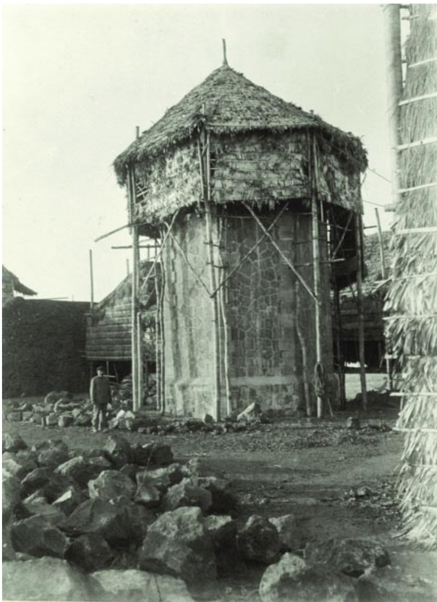
Marion: Faro de 1 er orden de Cabo Engaño: Estado de las obras el día 10 de enero de 1892 (Carpeta Islas Filipinas. Obras públicas. Faros ), 1893. PATRIMONIO NACIONAL
