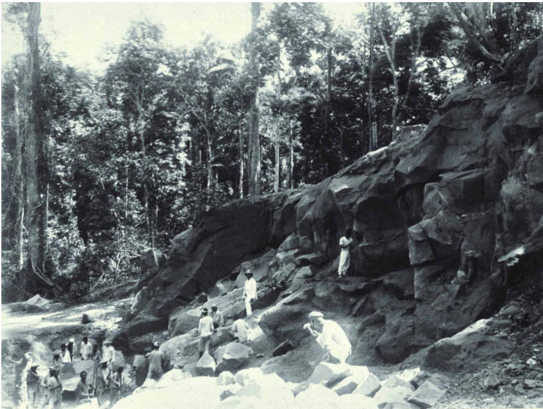
Marion: Faro de 1 er orden de Cabo Melville: Cantera de arenisca explotada para las obras (Carpeta Islas Filipinas. Obras públicas. Faros ), 1893. PATRIMONIO NACIONAL
