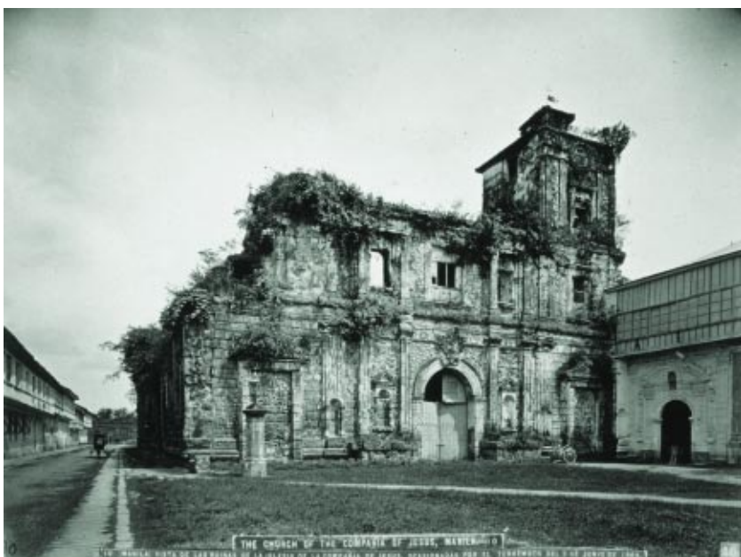
Vista de las ruinas de la Iglesia de la Compañía de Jesús, ocasionadas por el terremoto del 3 de junio de 1863 (Álbum Filipinas ), ca. 1870. BIBLIOTECA NACIONAL, Madrid
