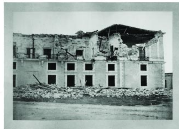
Martínez Hébert: Vista de la fachada N.E. de la Aduana de Manila, 1863. (Carpeta Terremotos de Manila ). PATRIMONIO NACIONAL
