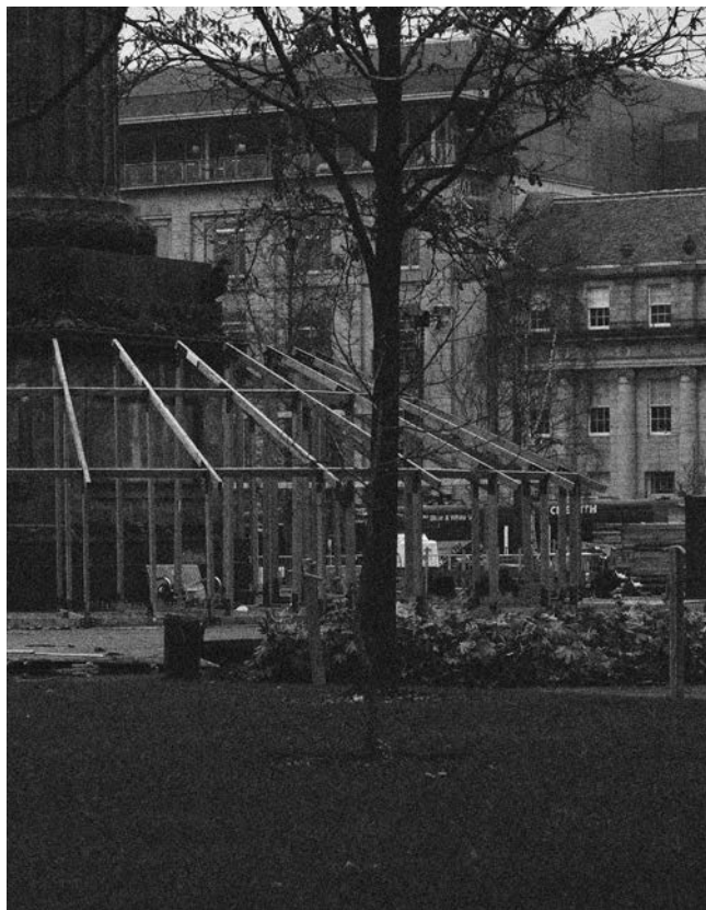
~Vista de la entrada del monumento con la madera que queda despues de la intervención ~View of the entrance of the monument with the wood that remained after the intervention.
